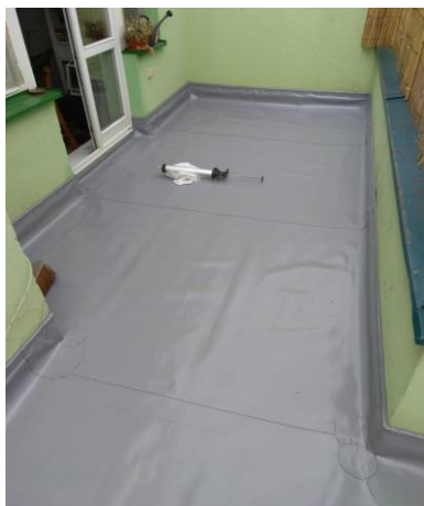
ukázka položení nové hydroizolace PVC
